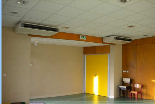
Pompe à chaleur air/air associé à 2 ventilo convecteurs
