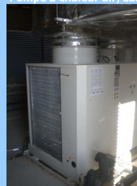
Pompe à chaleur air/air associé à 2 ventilo convecteurs
