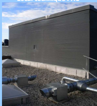
Pompe à chaleur air/air associé à 2 ventilo convecteurs
